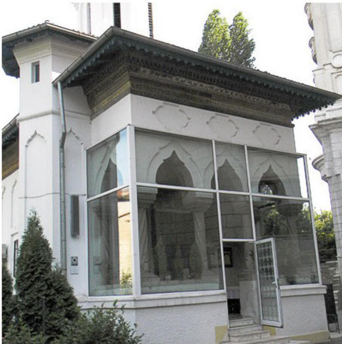
Figura 53: GREȘIT: Pridvorul Bisericii Schitul Maicilor din București, închis cu tâmplărie PVC și geam termopan
