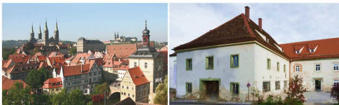
Figura 58: Mănăstirea benedictină din Bamberg, Germania. Aplicarea unui mortar izolant și monitorizarea comportamentului energetic al clădirii în timp, proiectul EFFESUS
