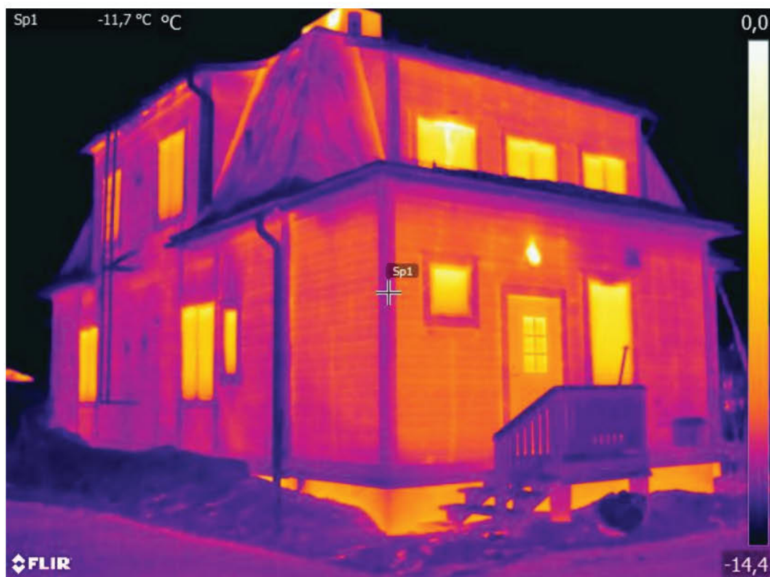
Figura 56: Studiu aprofundat al comportamentului energetic al clădirii
